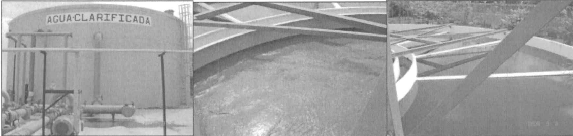
Fotografía No.2. Tanque de agua clarificada - Agua que entra al clarificador - Agua clarificada
